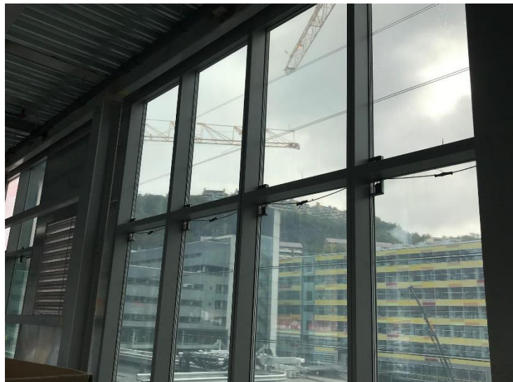
Figur 11 – Ved Haukeland sykehus er det integrert transparente solcellepaneler i flere av vinduene. Foto: COWI.
